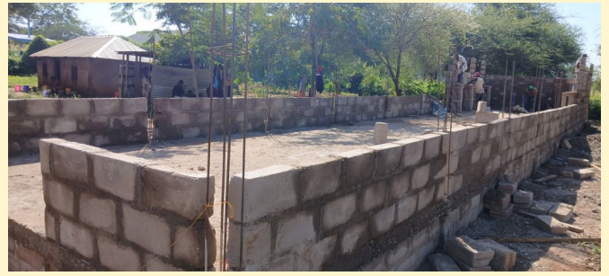
Das Fundament ist gelegt, der Boden ist gegossen und die ersten Schichten sind gemauert....
