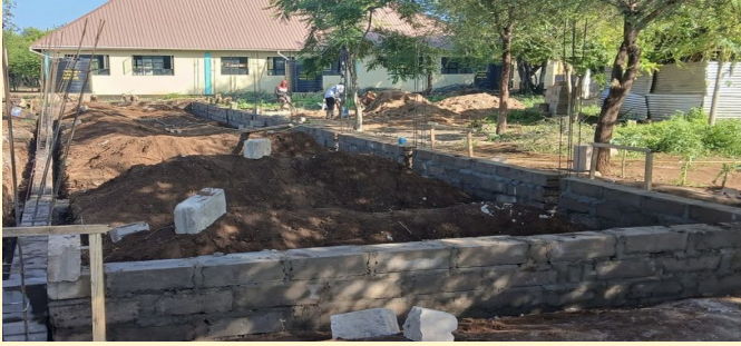
Das Fundament ist gelegt, der Boden ist gegossen und die ersten Schichten sind gemauert....
