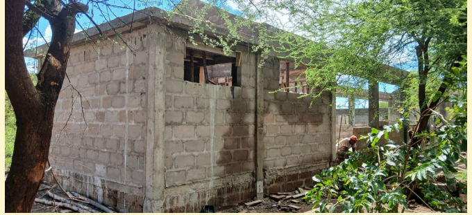
Das Fundament ist gelegt, der Boden ist gegossen und die ersten Schichten sind gemauert....
