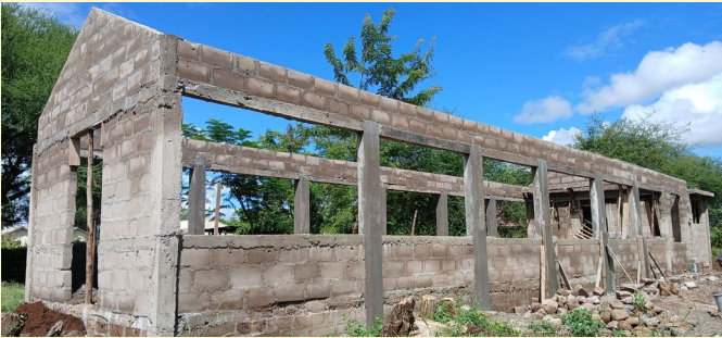
Das Fundament ist gelegt, der Boden ist gegossen und die ersten Schichten sind gemauert....
